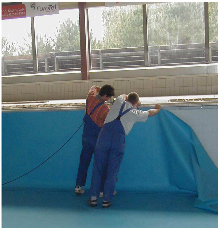
**Foto 5. Provádění stěny bazénu.**
