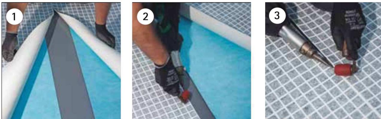
**Foto 2. Navařování fólie CERAMICS na podvařovací pás**
