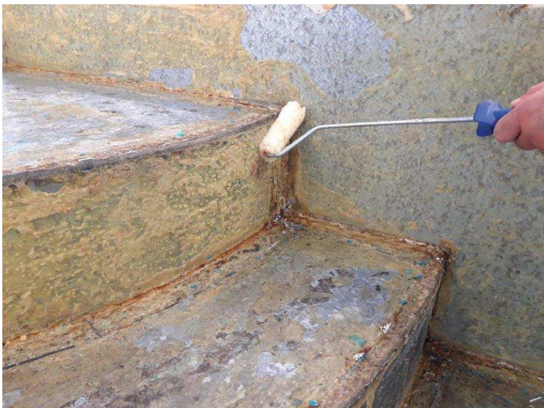
**Foto 7. Nanášení lepidla na podklad**
