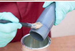
An den Innenseiten des Fittings in Längsrichtung von innen nach außen eine Schicht Klebstoff auftragen. Auf dieselbe Weise eine Klebstoffschicht auf das Rohr auftragen. Die Größe der Pinsel muss auf den Rohrdurchmesser abgestimmt werden. Den Klebstoff im Verhältnis 1/3 auf das Fitting und 2/3 auf das Rohr auftragen.
